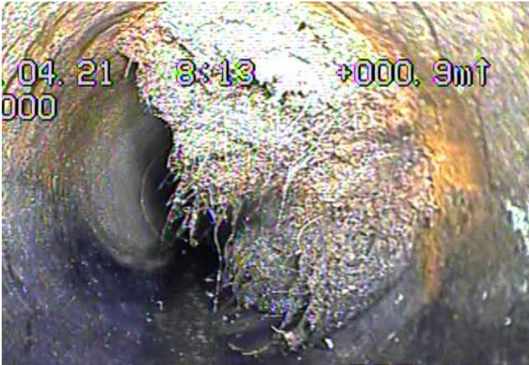
Eine Kanalbefahrung im Bereich Neuhammer hat eine starke Verwurzelung zum Vorschein gebracht. Diese wurde entfernt, um einen besseren Ablauf des Abwassers zu erreichen.
